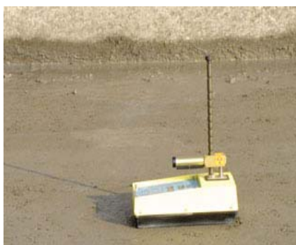
Kiểm tra độ chặt BTĐL bằng máy phóng xạ HS - 5001C
