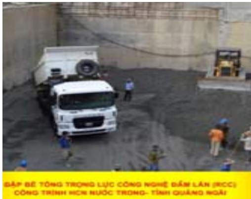
Hình ảnh thi công đập bê tông trọng lực RCC
