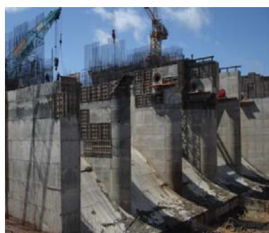
Hình ảnh thi công CTĐT Seperok 4
